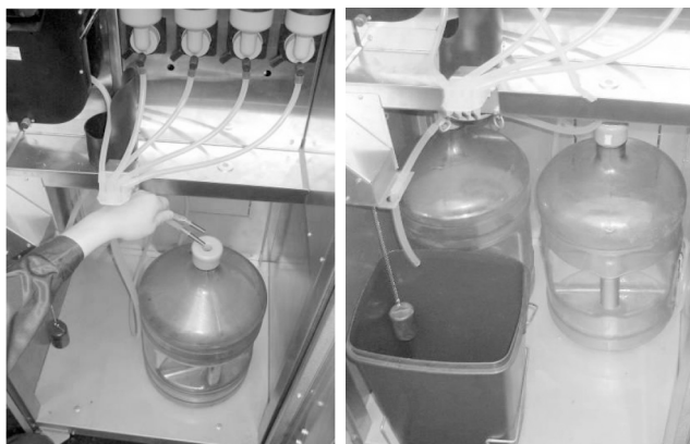
Рисунок 26 - Установка автономного комплекта водоснабжения
